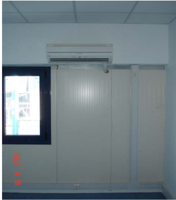
Εικόνα 1 Εσωτερική μονάδα (indoor unit) κλιματιστικού διαιρούμενου τύπου
