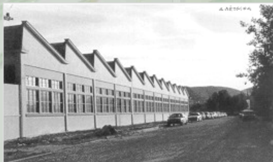
Μέρος των γραφείων και των εργαστηρίων του Τμήματος στεγάζονται στο ανακαινισμένο εργοστάσιο Παπαρήγα (φωτογραφία του 1950)
